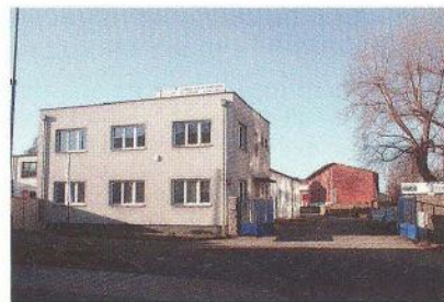
Výrobní budova firmy Tronic
